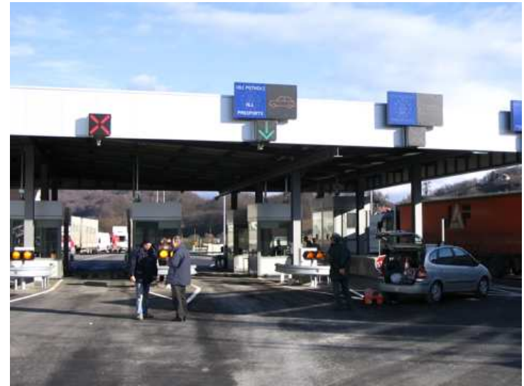
PRZEJŚCIE GRANICZNE (SŁOWENIA-CHORWACJA)
