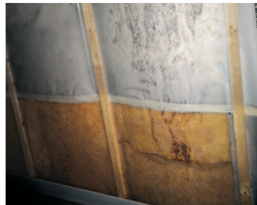
Poškodenie v dôsledku použitia vlhkého dreva v kombinácii s konvenčnou parozábranou.
