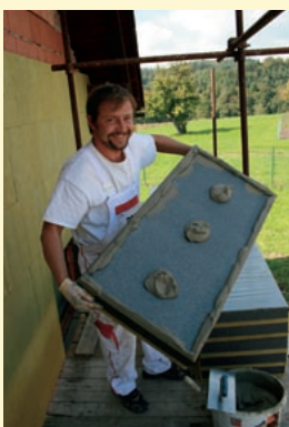
Nanášení lepicí hmoty se provádí ve formě obvodového věnce a tří bodů uprostřed desky
