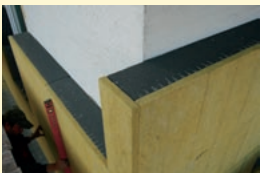
Příklad řešení detailu vazby rohu budovy pomocí rohové desky Isovex TWINNER
