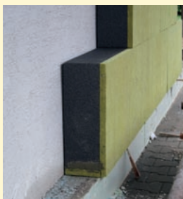
Požární oddělení plochy zateplení od tepelné izolace soklu pomocí zakládací desky Isovex TWINNER
