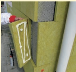
Příklad řešení detailu vazby rohu budovy pomocí dodatečně lepené uzavírací desky Isovex TF PROFÍ tloušťky 30mm.
